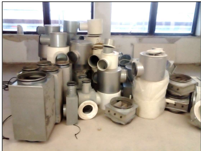
Brukte, runde ventilasjonskanaler og kanalbend - demontert og grovsortert i KA13. Foto: Anne S Nordby
