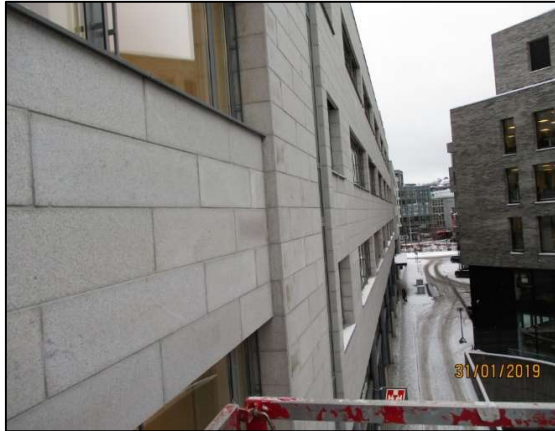
Fasade i Drammensveien 134. Foto: Noora Khezri
