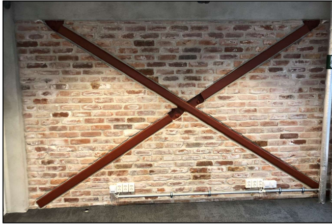
Oppmuring og ferdig brannvegg. Foto: Rune Andersen
