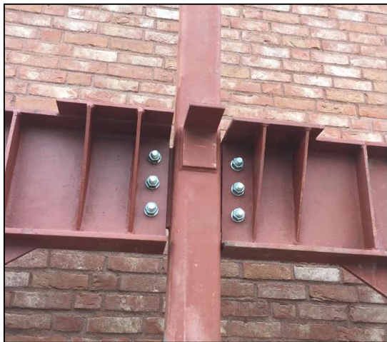
Montering av brukt stål på plassen. Foto: Stokke Stål
