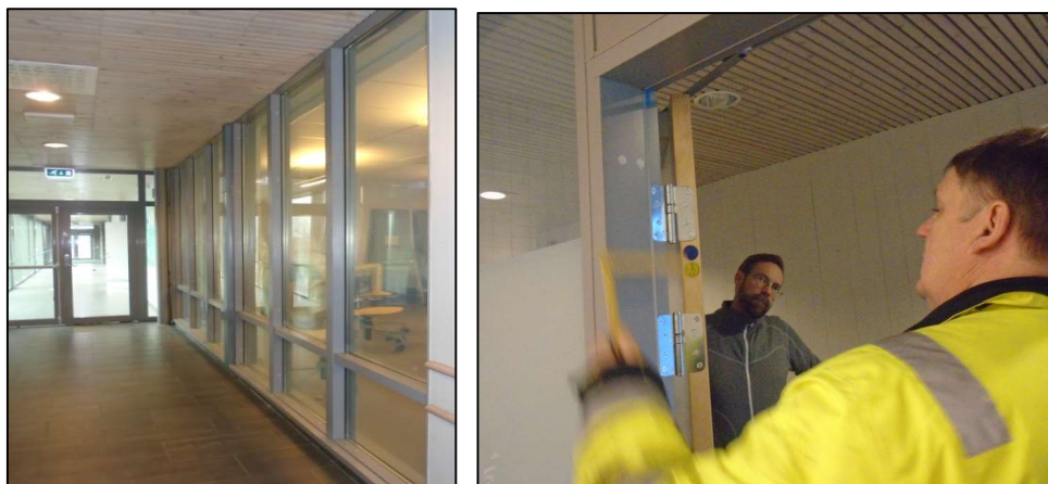
Fra befaring på Refstad skole. Foto: Anne S Nordby
