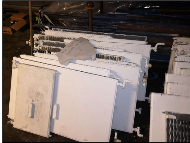
Lagring før spyling og trykktesting. Foto: Anders Sand
