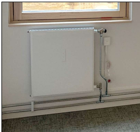
Ferdig montert etter bearbeiding. Foto: Randi Lunke
