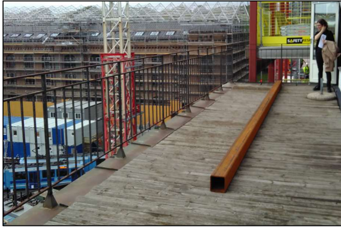
Rekkverk i 8 etg, opprinnelig situasjon. Foto: Anne S Nordby
