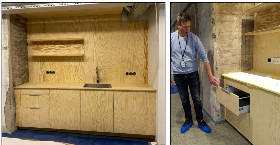
Skrog ferdig montert med nye fronter i 15 mm kryssfiner. Foto: Lars Ulrich Nielson/LUN og Anne S Nordby
