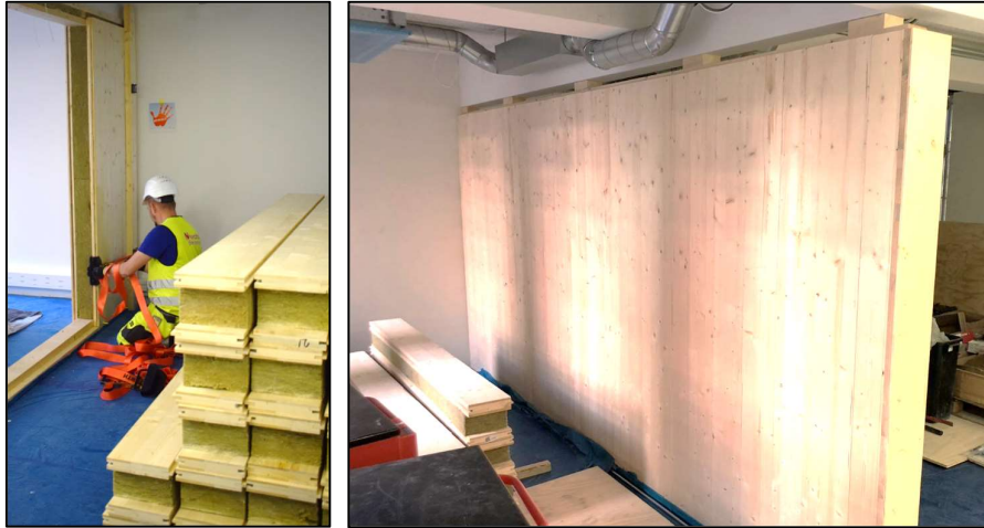
Montering av Tewo-vegger. Foto: Anne S Nordby og Rune Andersen
