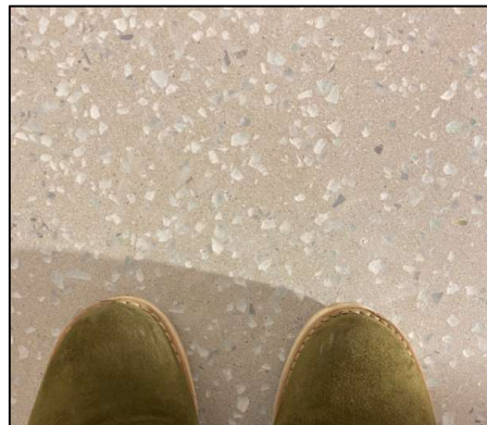
Glassbetong: Betonggulv med gjenvunnet fasadeglass. Foto: Kristine Aassved Storeide
