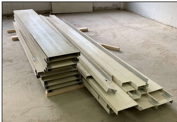
Kabelbaner etter demontering. Foto: Randi Lunke
