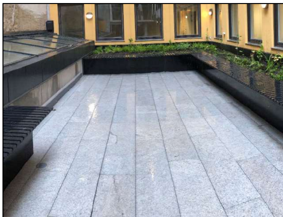
Ferdig granittgulv i KA13. Foto: Janicke Ramfjord Egeberg
