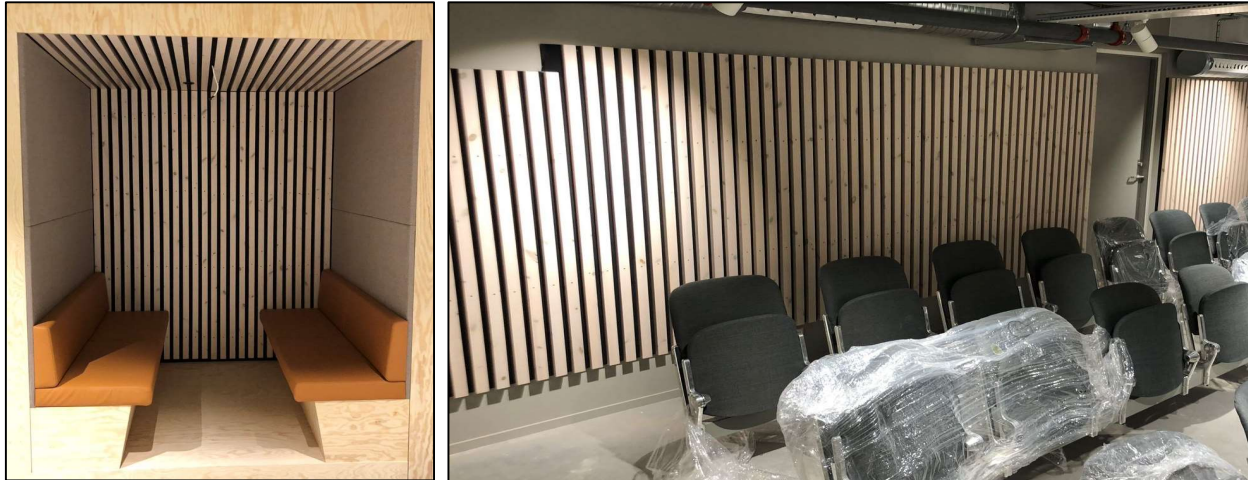
Ferdige sittebåser og kledning av brukte spiler på bakvegg i kinorom. Foto: Rune Andersen
