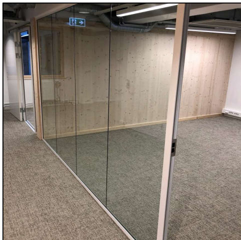
Ferdig monterte fronter. Foto: Rune Andersen
