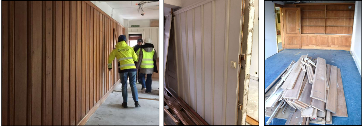
Kledning og innredning i furu beholdt og delvis omplassert. Foto: Catriona Shine, Rune Andersen og Anne S Nordby
