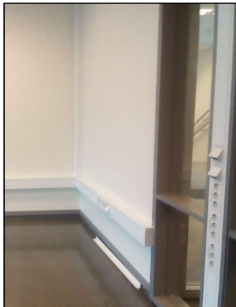
Veggkanaler på Refstad skole. Foto: Anne S Nordby
