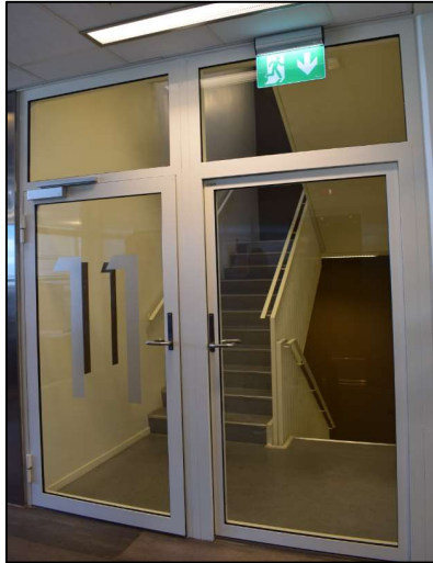
1-2: Dørfelt fra DEG8, overliggende glassfelt fjernet og dør montert i KA13 med ny låssylinder. Foto: Anne S Nordby 3: Brukt branndør, ferdig montert og lakkert. Foto: Rune Andersen
