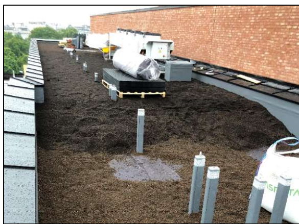
Gjenbruksjord legges på taket. Foto: Rune Andersen
