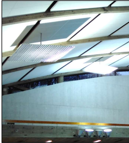
Reflektorer ble demontert fra taket på Tøyenbadet, lagret og til slutt montert i lyssjakt i KA13. Foto: Anne S Nordby
