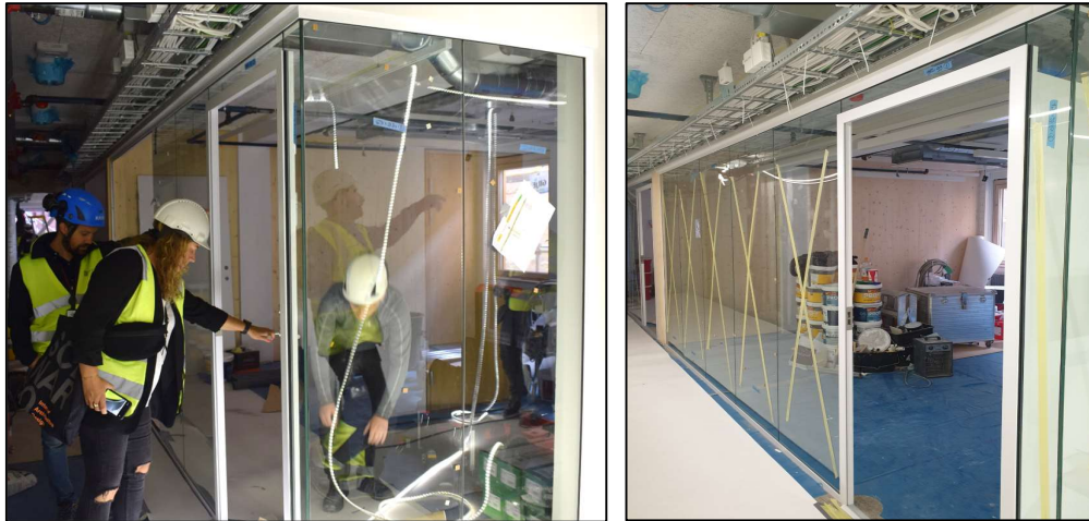
Montering av glassfronter/ kontordører. Foto: Anne S Nordby og Noora Khezri
