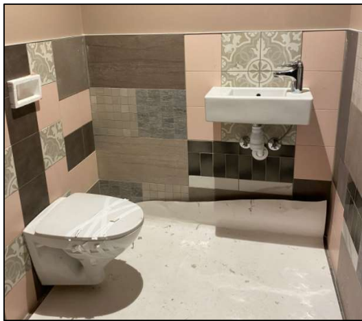
Ferdig mosaikk av restfliser på toalettrom. Foto: Kristine Aassved Storeide
